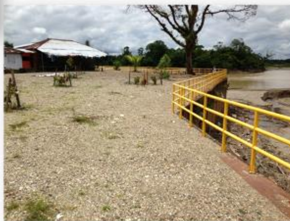
Construcción de un muro de contención de tablaestaca – Paimadó Municipio de Río Quito
